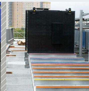
Posadowienie pasmowe na tworzywie Sylomer®
