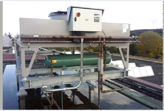
Sprężysta izolacja wieży chłodniczej na izolatorach Isotop® DZE
