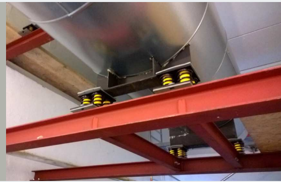
Posadowienie wymiennika ciepła spalin na stalowych amortyzatorach sprężynowych Isotop® DSD-BL
