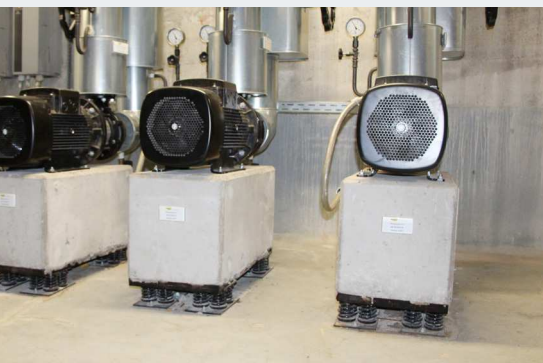
Posadowienie pompy na stalowych sprężynach Isotop® (izolatorach blokowych)
