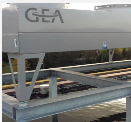
Odporne na siły zrywające posadowienie wieży chłodniczej na izolatorach Isotop® DZE
