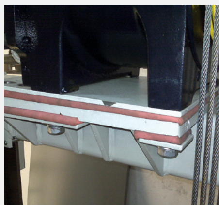
Dwustronnie sprężyste łożyskowanie izolatorami Isotop® SE-DE, bęben liny w górnej części szybu
