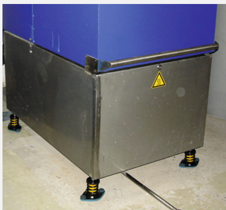
Mały agregat kogeneracyjny odizolowany za pomocą izolatora Isotop® DSD i stopki FP/K
