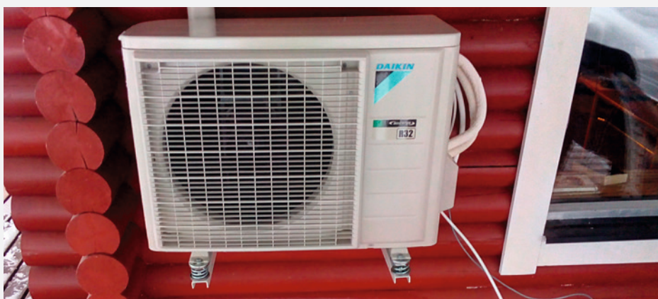
Posadowienie zespołu zewnętrznego na elementach z tworzywa Isotop® MSN
