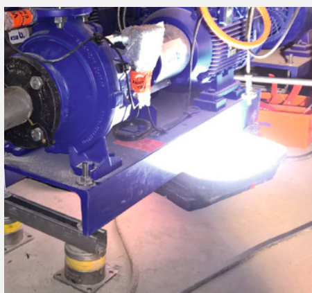
Podkłady pomp bez dodatkowej masy (fundamentu) za pomocą izolatorów Isotop® DZE
