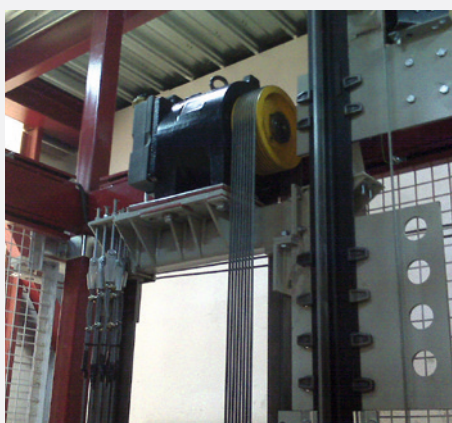
Izolacja napędu za pomocą wstępnie naprzężonych łożysk z tworzywem Sylomer®
