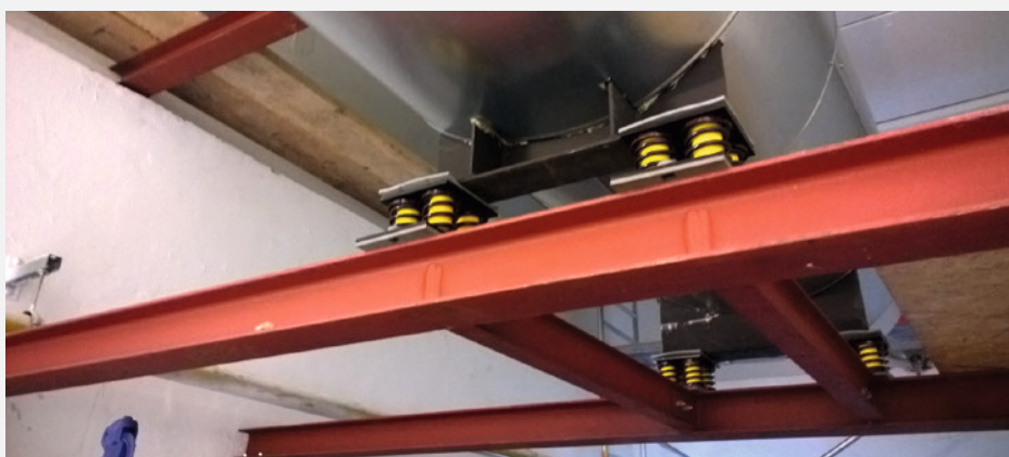
Posadowienie wymiennika ciepła spalin z izolatorami Isotop® DSD-BL
