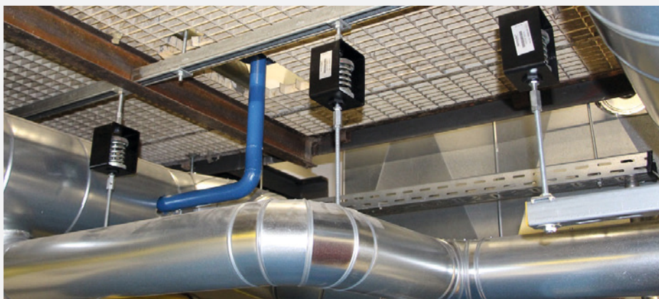
Przewody rurowe izolowane za pomocą izolatorów Isotop® SD/Z
