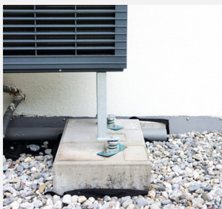
Posadowienie zespołu zewnętrznego na podłożu (fundamencie) z użyciem podkładek z tworzywa Isotop® Elementy MSN
